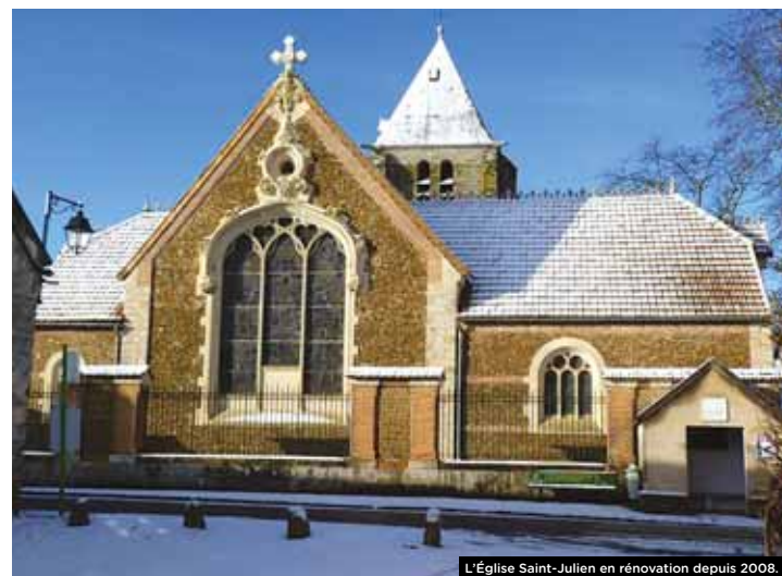
L'Église Saint-Julien en rénovation depuis 2008.
